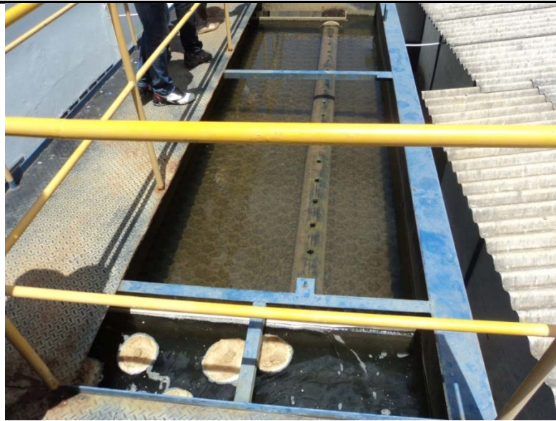
Figura 3.2.1 – Estação de tratamento de água CEDAE – Trajano de Moraes – Vista externa.
